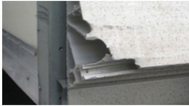
↻ Ladebordwand: Deformationen der Plattform, die nicht auf wirtschaftliche Weise repariert werden können, gebrochene oder unvollständige Verkleidungen
