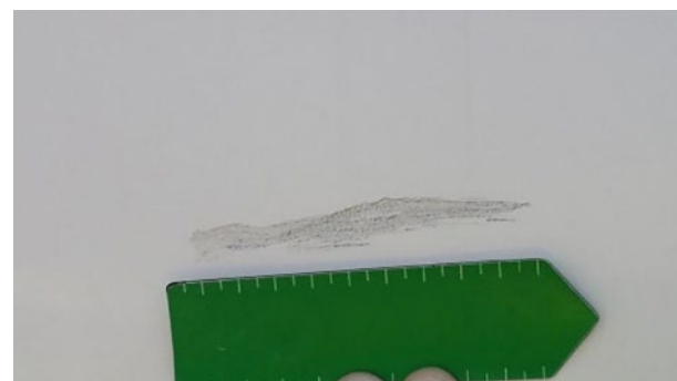
Seitenwände: Leichte Kratzer mit Materialabtrag \leq 20 cm
