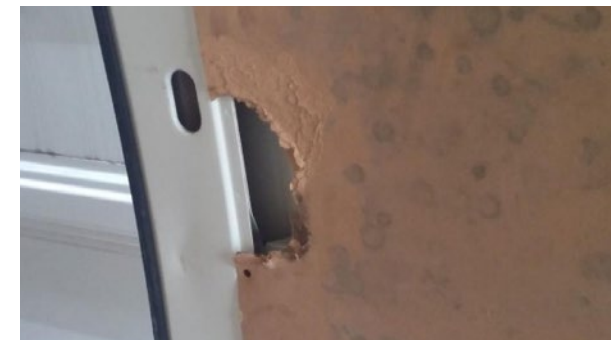
Holzvertäfelung innen: Stoßspuren, gerissene Tafeln, fehlende Tafeln (außer obere Tafeln an Türen)
