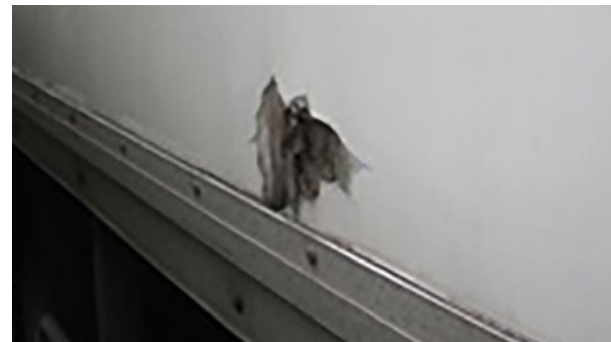
Holzseitenverkleidungen: Beschädigte Holzstütze \geq 20\text{ cm}
