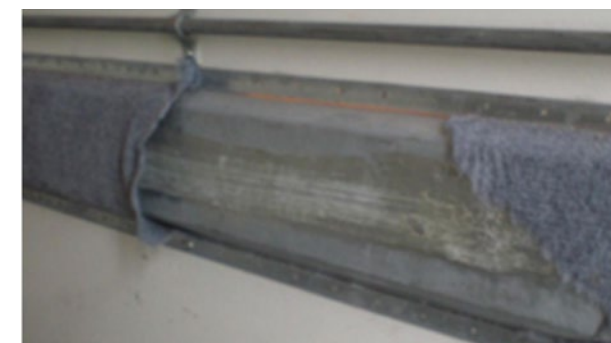
Polsterung und Stangen: Teppich gerissen oder abgelöst
