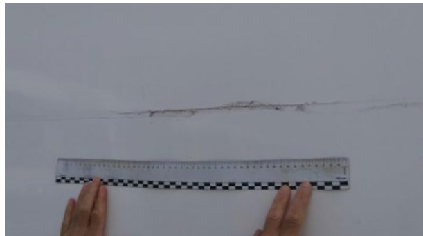
Seitenwände: Kratzer mit Materialabtrag \geq 20\text{cm} , kann auf wirtschaftliche Weise repariert werden. Möglichkeit der Lackierung der Halbverkleidung
